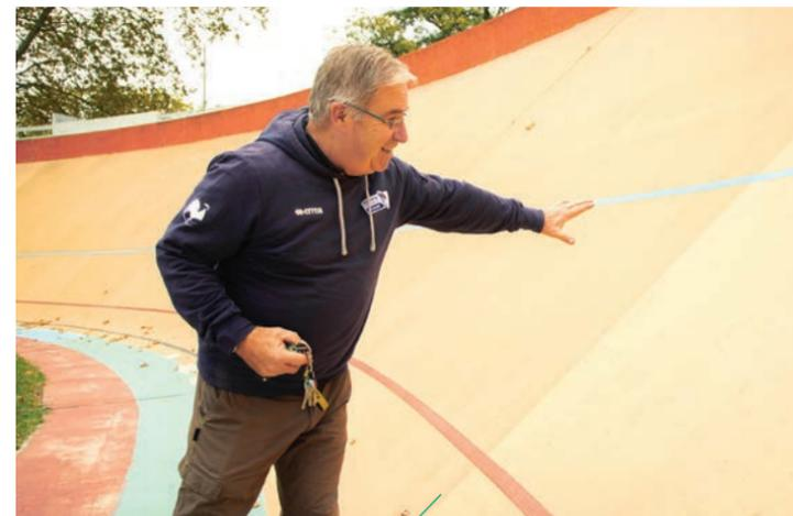
**“ Pour absorber la force centrifuge des coureurs à pleine vitesse, la piste est bâtie avec une pente à 44°. En rouge la ligne des sprinter, qui sert à délimiter le couloir des coureurs de vitesse lors des compétitions. En bleu, tracée à un tiers de la largeur totale de la piste, la ligne des stayer, utilisée dans le demi-fond.”**
